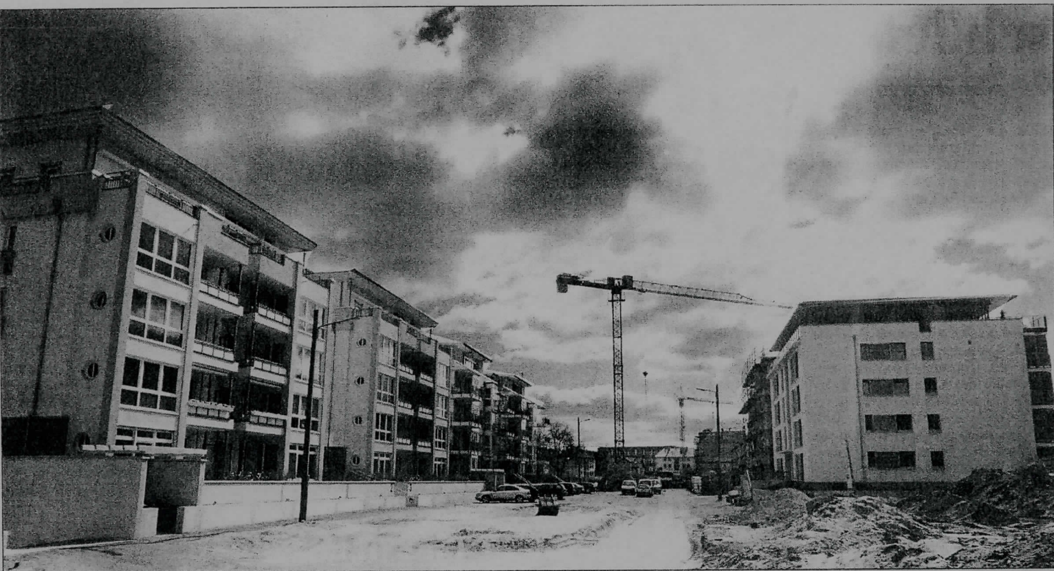
Wohnen am Giersberg. Das zurzeit ehrgeizigste und anspruchsvollste Bauvorhaben in Braunschweig.
